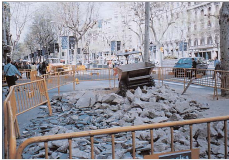
Residuos de construcción.
